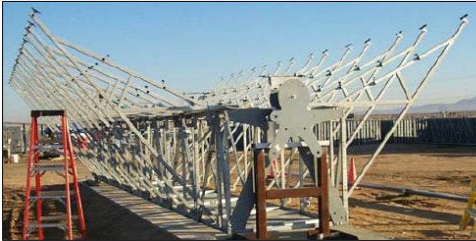
Figura 0.10. Estructura de un módulo Eurotrough
