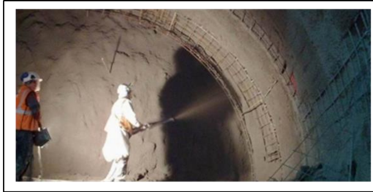
Fig 7.8 Lanzamiento de shotcrete Fuente: Hard Rock, Shotcreting (Dr. Sauer & Partners) [53].
