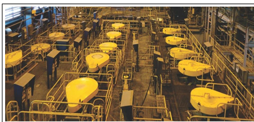
Fig. 3.10. Celdas de flotación. Fuente [39]
