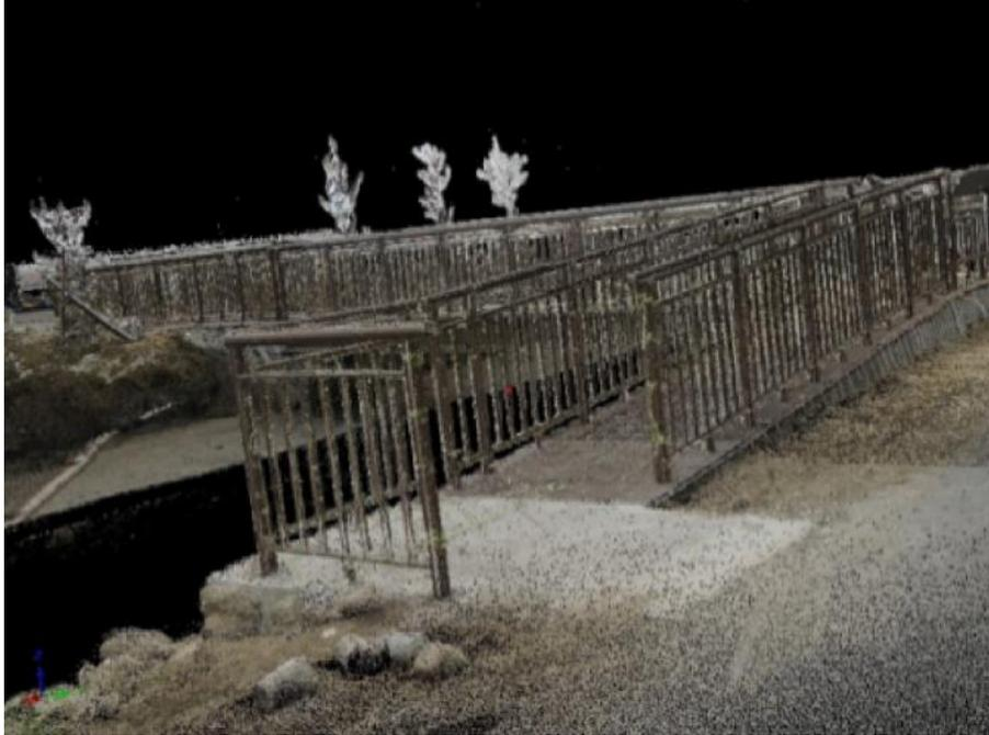
Figura 1.4 Puente de plástico reforzado con fibra
