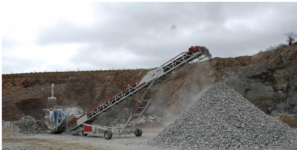
Figura 1.3 Apilamiento de piedra chancada mediante un apilador telescópico radial. Fuente: Telestack, Telestack Aggstack range demonstrating outstanding results [16].
