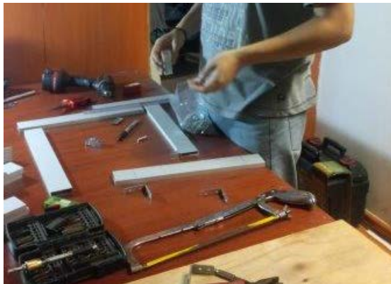
Figura 36 Construcción de la base
