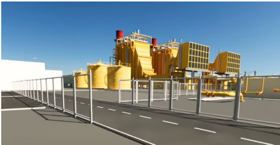
Figura 1.8 Vista virtual de la Central Térmica Fénix [65]
