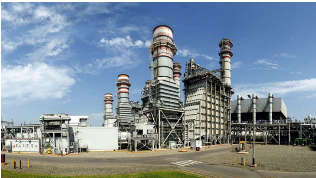
Figura 1.7 Vista de las Chimeneas de Turbinas de Gas, Calderas de Recuperación de Calor y Aerocondensadores [64]
