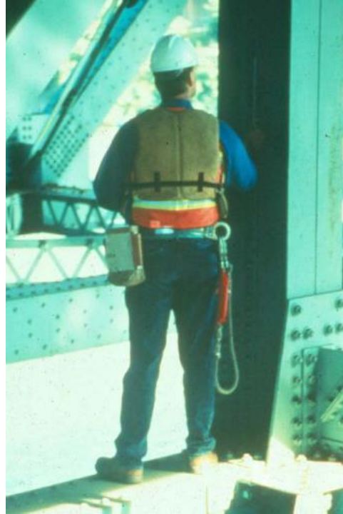
Figura 7. Inspector con casco, chaleco salvavidas, chaleco reflector y arnés (Tomado de [23])
