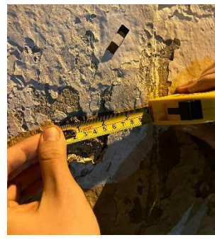
Paso 4. Medición con wincha
