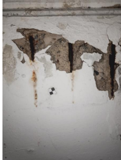
Figura 23. Descascaramiento en una viga
