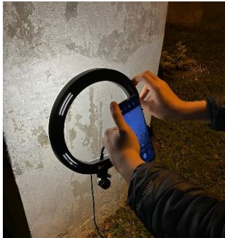
Paso 1. Ubicación e iluminación de zona dañada
